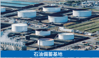
石油備蓄基地
