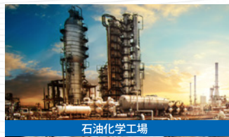
石油化学工場
